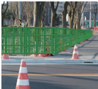
竹プラフェンスの設置例
