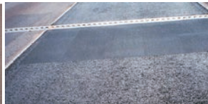
ジョイント部の段差修正
