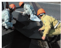
ジョイント部の補修箇所の保護
