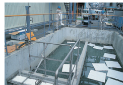
▲油水分離槽の浮上油の回収に
