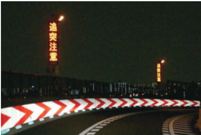
近畿道・門真JCT シングル専用架台 照明柱設置
