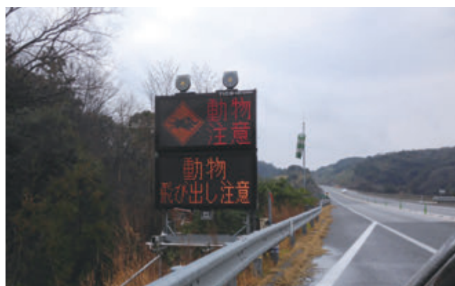
浜田自動車道 簡易標識
