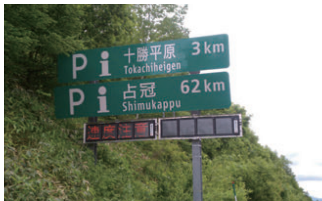
道東自動車道 シングル専用架台
