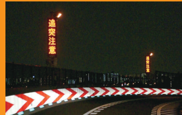
近畿道・門真JCT 集中工事(シングル縦照明柱設置)
