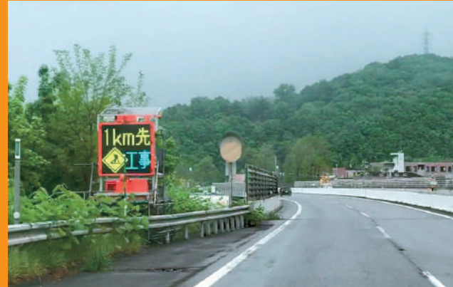
札幌自動車道 IC改築工事
