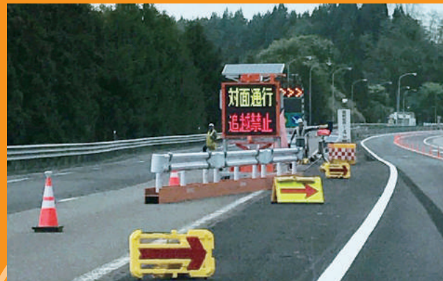
東北自動車道 床板取替工事
