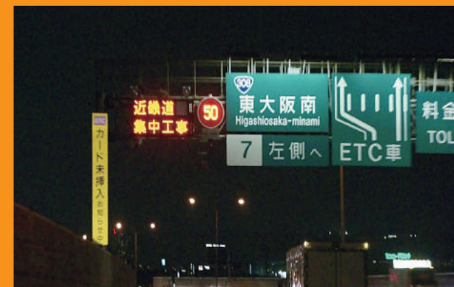
近畿道 集中工事(横2連門柱設置)
