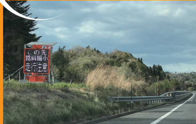
常磐自動車道 4車線化工事
