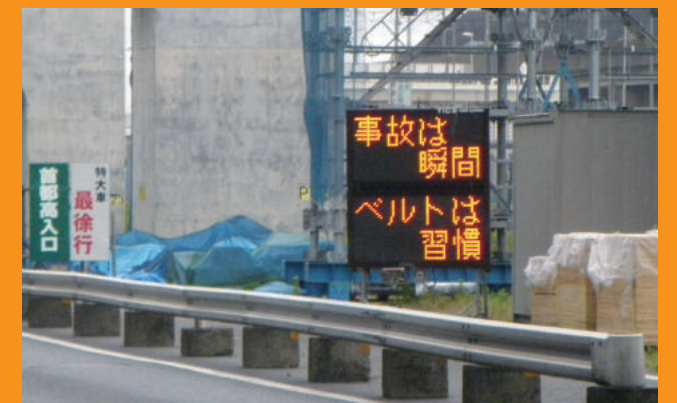
新木場地区 工事(簡易標識)
