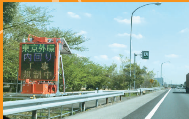
外環自動車道 集中工事
