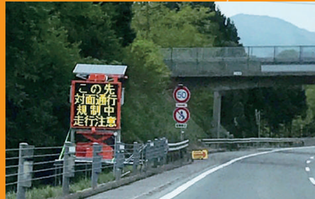
東北自動車道 床板取替工事
