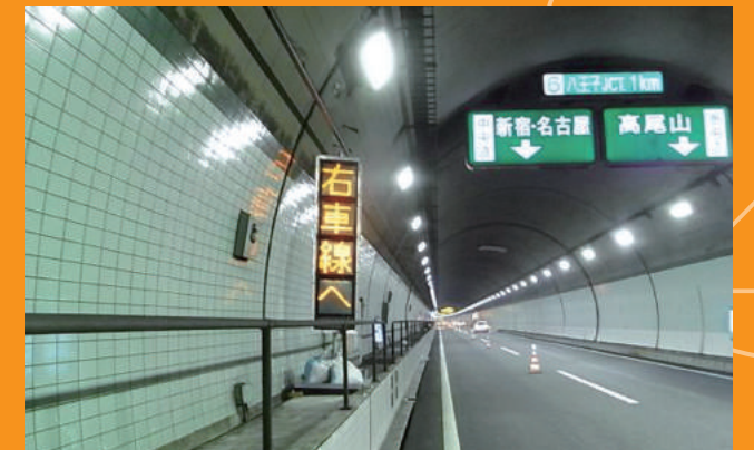
中央道 八王子城跡トンネル 工事 (シングル縦)
