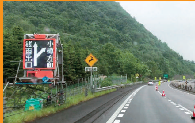
札幌自動車道 IC改築工事
