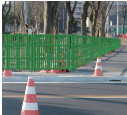
竹プラフェンスの設置例
