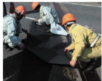
ジョイント部の補修箇所の保護
