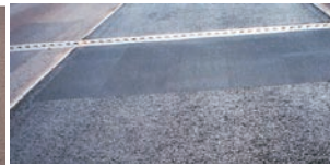
ジョイント部の段差修正
