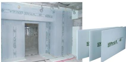
限界を越した断熱性能(熱伝導率0.022W/m・k)(23℃)
