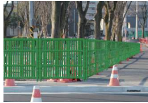
竹プラフェンスの設置例
